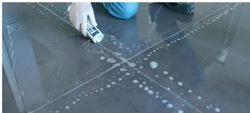
FILLER est un mastic silicone monocomposant, facile à mettre en œuvre et à lisser de façon optimale.
