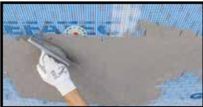
Remplissage et lissage de la natte, spatule crantée dans le sens vertical
