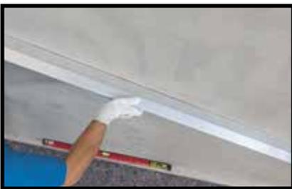
Contrôle planéité de l'enduit structurel
